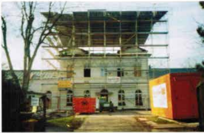
Villa Scheidt: Nach dem Brand war das Dach stark beschädigt, so dass die Arbeiten unter einer provisorischen Zeltüberdachung begonnen werden mussten
